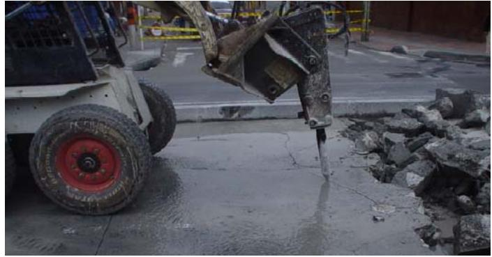
Seguidamente se retirará mediante cargue las losas demolidas mediante el uso de retrocargador de llantas o similar y volquetas.
